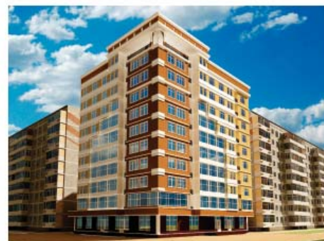
Исанова/Боконбаева (на стадии строительства)
