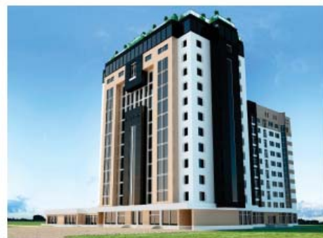
Правда/Фрунзе (на стадии строительства)
